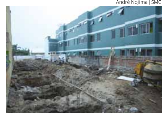
Fundação do novo prédio já está quase pronta
